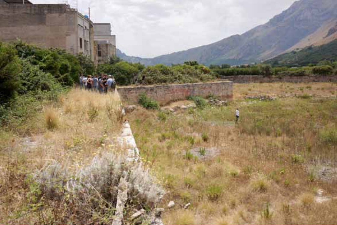
L'antica diga e la zona precedentemente occupata dal lago.
